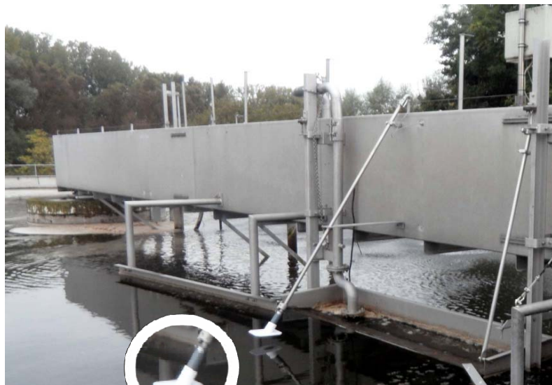
Oberflächenabtaster zum sicheren Erkennen von Schwimmschlamm
