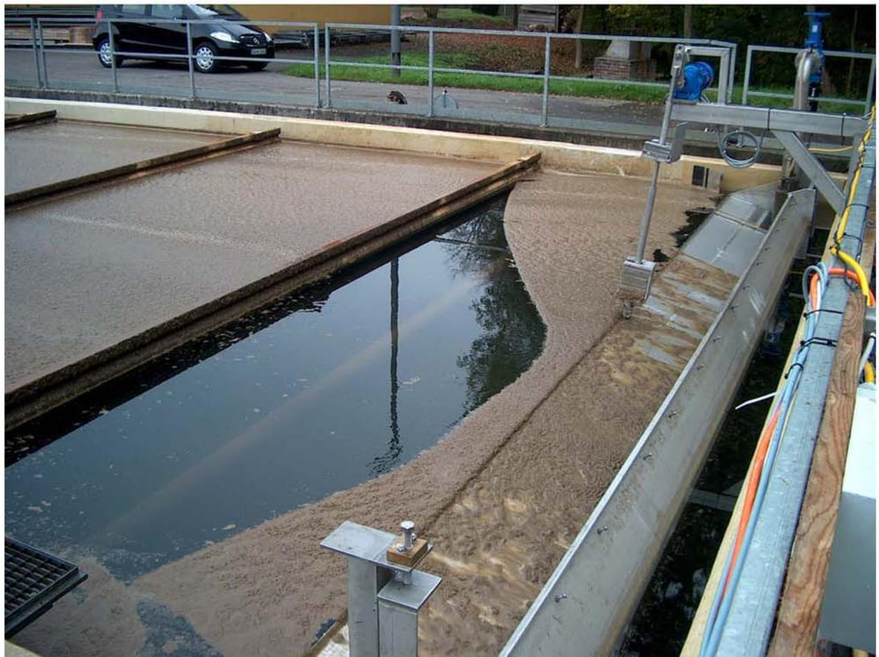
“Sogwirkung” einer vollautomatischen, selbsjustierenden Skimrinne
